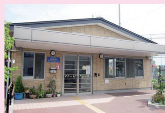
庄所子育てすくすくセンター
